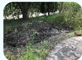
作業後の様子（復元池）
